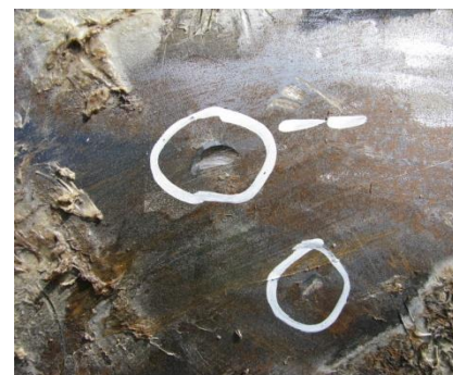
pioche / canalisation acier gaz HP
