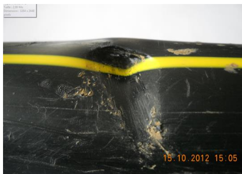
barre à mine / canalisation PEHD gaz MPB
