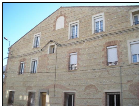
Réseau aérien BT à conducteurs isolés en façade
